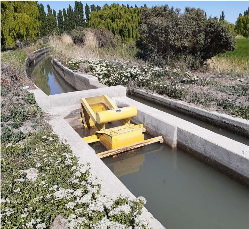
*Compuerta automática instalada en un canal revestido.*
