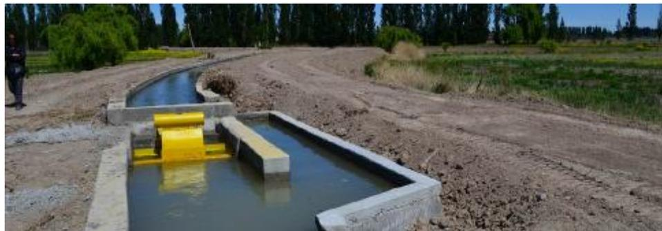
**Foto II-15: Compuerta Automática en Mejoramiento de Canales – VIRCH [FEP]**
