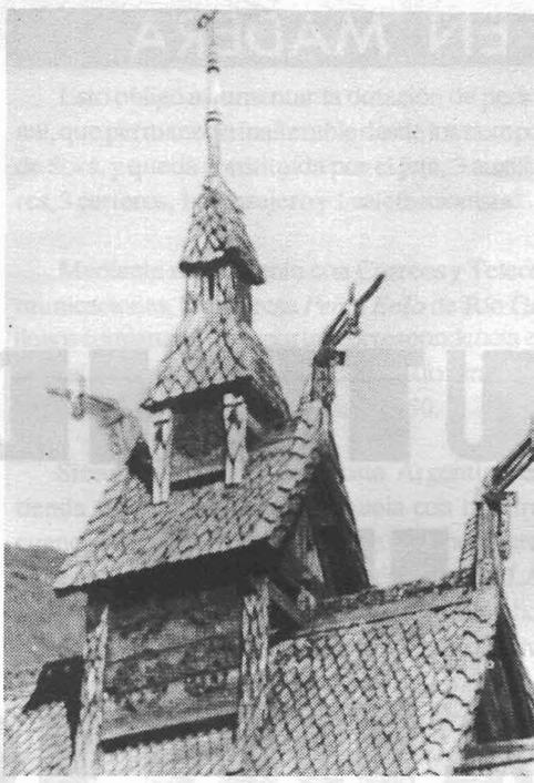
Detalle de la cubierta de una iglesia construida con el método *stav*, Noruega, ca. 1200.
