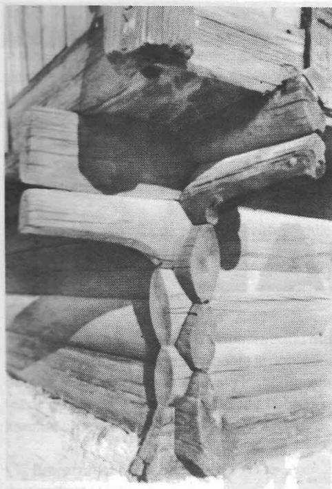
Detalle de una esquina de construcción en madera según el método *laft*, ca. 1650.
